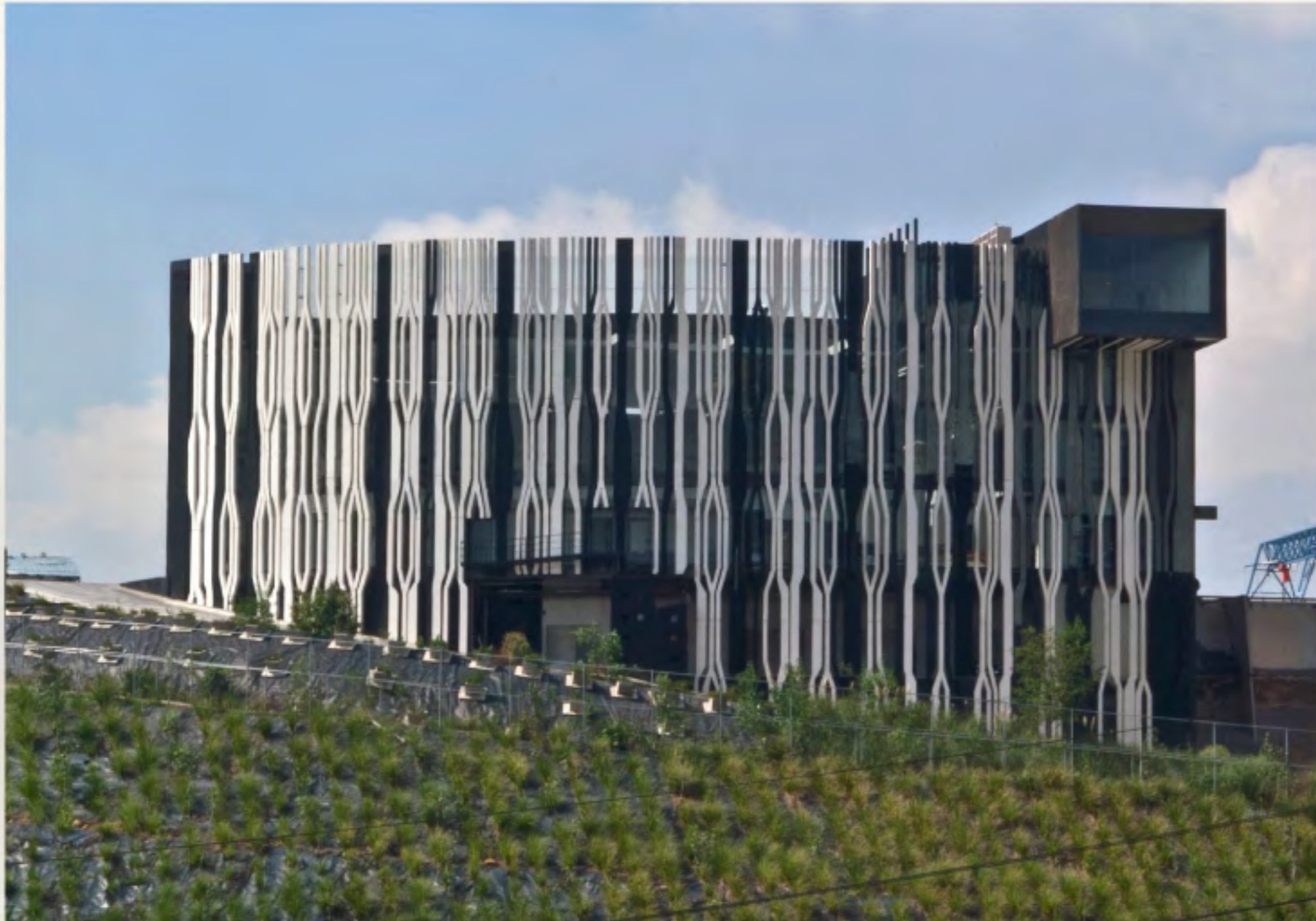
Edificio BAF, oficinas corporativas de Fapresa, Atizapán de Zaragoza, México.
