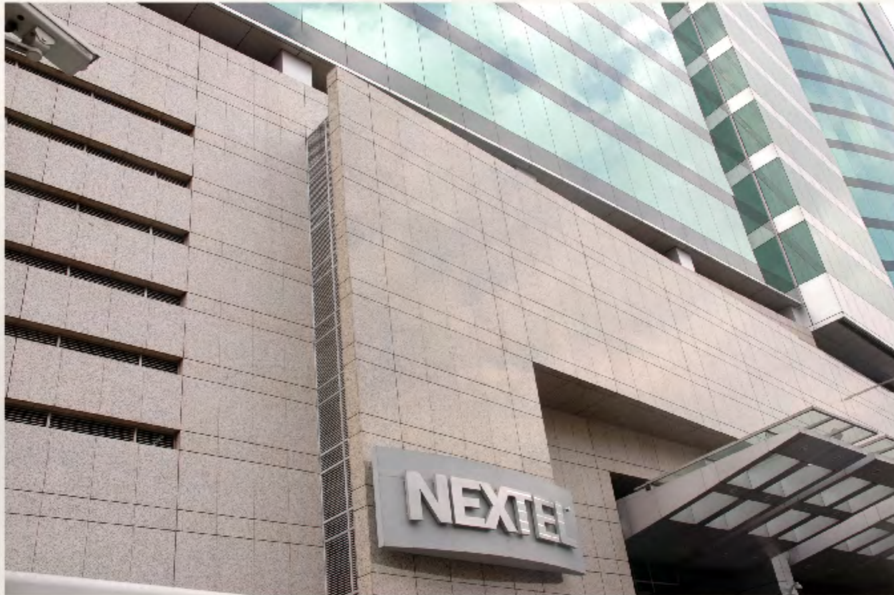
Torre Esmeralda II, oficinas corporativas. Prefabricados adosados en granito.
