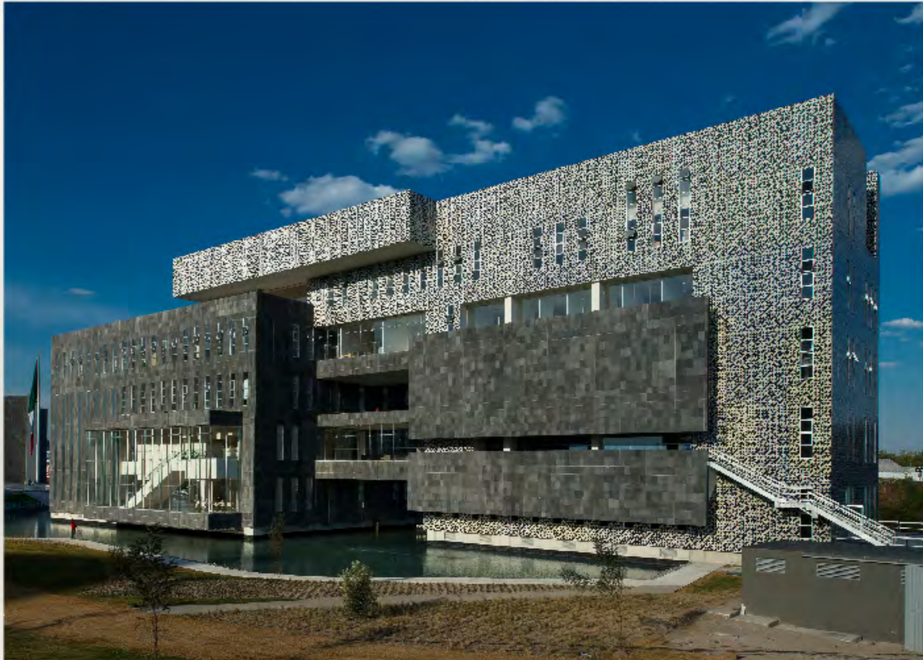
Centro Integral de Servicios Puebla, Pue. Obra realizada en adosados de talavera y recinto negro
